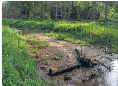
Die Sohlgleite ist das Kernstück. Die Schüttung aus Steinen bildet eine Staustufe im Nonnenbach. Dadurch wird der Wasserspiegel im Wald angehoben.
